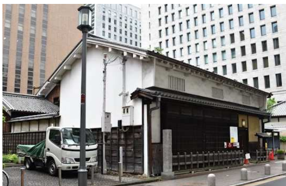
図 28.2 船場大火後の建築とされる適塾（重要文化財）
