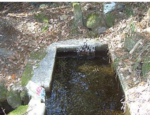
◀ 砂溜り(沈砂池) 砂やゴミを除去する
